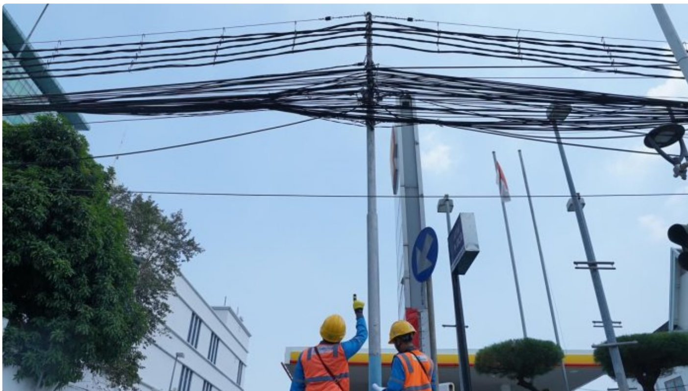
Photo: Titik Lokasi pencuri Kabel PLN
